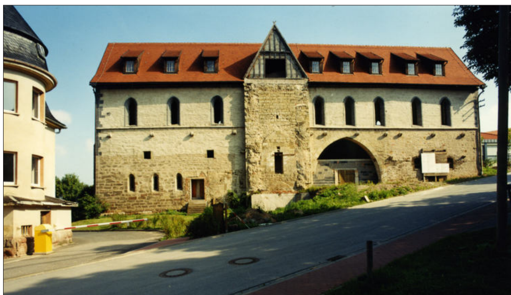
Abb. 13. Rohr, Lkr. Schmalkalden-Meiningen. Die Kirche des Benediktinerinnenklosters von Süden. Die Lage des abgebrochenen Glockenturmes ist deutlich zu erkennen. Nach Südosten folgt ein spitzbogiger Torbogen, der zu einem Anbau an dieser Stelle gehörte (Foto 1998, TLDA Erfurt).
