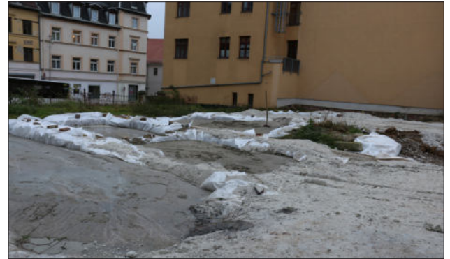
Abb. 11/12. Altenburg, Lkr. Altenburger Land. Die Kirche der Magdalenerinnen war ca. 29 x 11 m groß. Ihre Fundamente konnten bei Ausgrabungen teilweise freigelegt werden. Die Grabungsfläche wurde 2017 verschlossen, mit Vlies abgedeckt und mit Flüssigbeton verfüllt. Blick von Südwesten.
